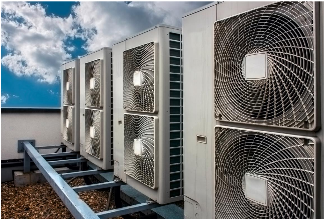
Abbildung 1: Filteranlage für Belüftungssystem
