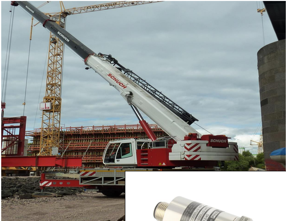
Abbildung 1: Baumaschine mit hydraulischem Hebesystem auf der Baustelle: Neue Rheinbrücke Mainz-Wiesbaden
